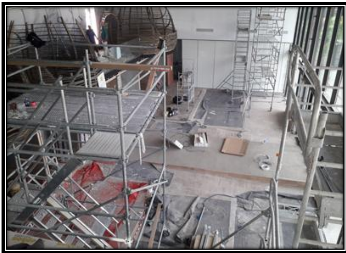
Grue, Nacelle, Echafaudage
